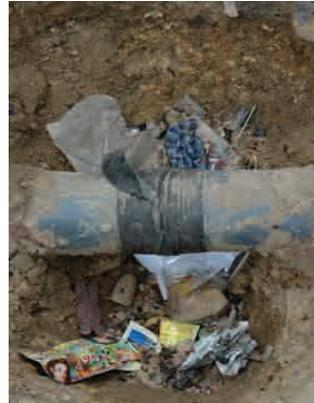
写真 S32.1.2 ゴムチューブで補修されている 100mmPVC 管
