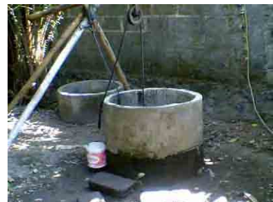
左：上記地点の湧き水集水施設（3L/秒： 密閉され衛生的）。
