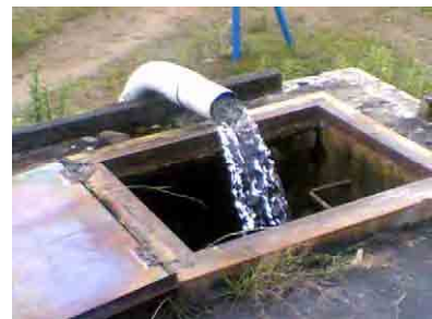
左：浅井戸は民地を借り建設されていた。 近くに河川があり、深度 10m 弱、15L/ 秒（右写真は貯水タンクに注がれる 浅井戸の水）。深井戸の水は鉄分濃 度が 4.5mg/L と高く処理が必要である。
