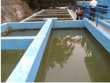
左：ジョグジャ市 PDAM の KR Gayam 施設（沈殿地）。5 深井戸、1 浅井戸と湧水で 150 L/秒の能力。東部に給水する。 右：ジョグジャ市近郊の耕田請負人による農作業。
