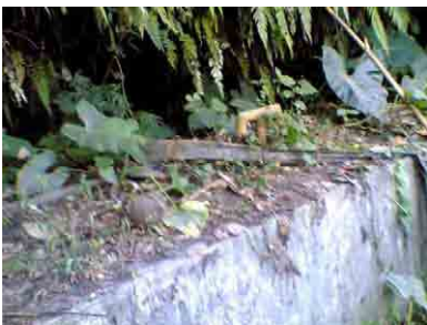
左：上記地点の湧き水集水施設（3L/秒： 密閉され衛生的）。
