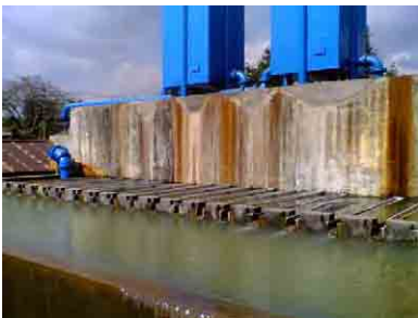
左：鉄分濃度が高い深井戸水の処理施設 (10L/秒の井戸能力に対し能力不足)
