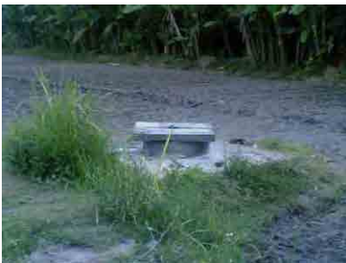
左：浅井戸は民地を借り建設されていた。 近くに河川があり、深度 10m 弱、15L/ 秒（右写真は貯水タンクに注がれる 浅井戸の水）。深井戸の水は鉄分濃 度が 4.5mg/L と高く処理が必要である。
