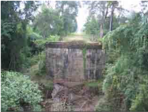
No. 26+100 Ngan Bridge
