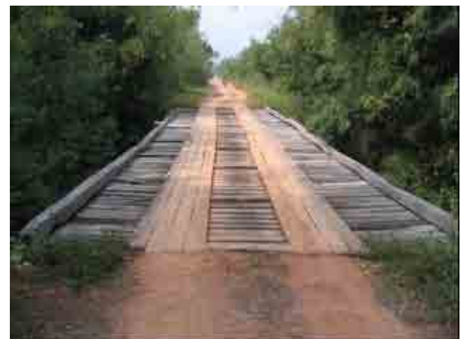
No.14+800 Dua Ngai Bridge
