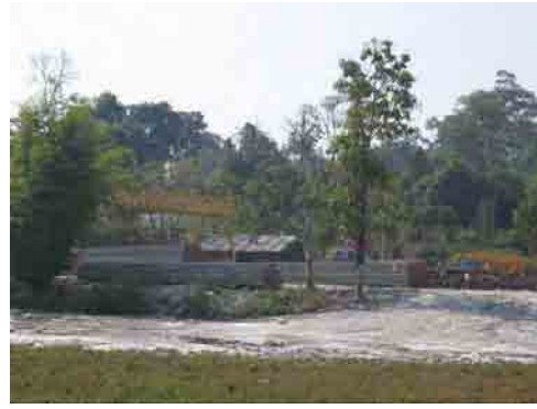
プレキャストコンクリート電柱工場
