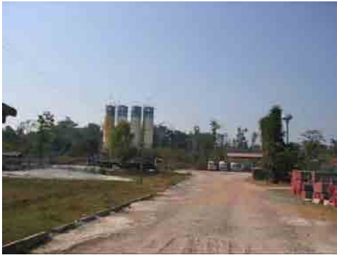
コンクリートプラント
