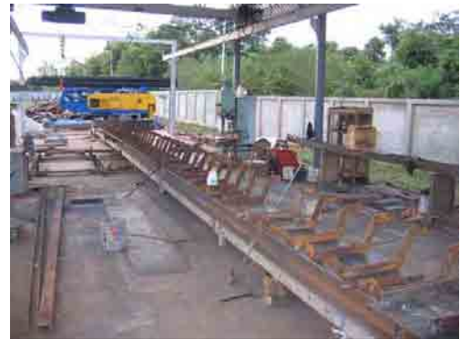
PC 桁製作用鋼製型枠の作製
