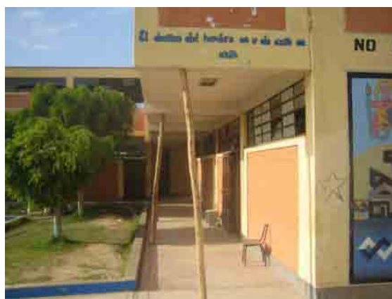
写真一 2 : 教室棟の床落下防止
