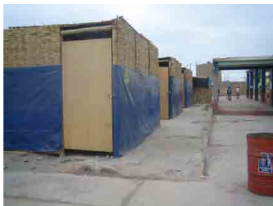
写真一 4 : 仮設校舎
