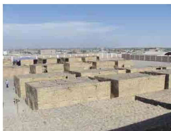
写真—4：仮設校舎
