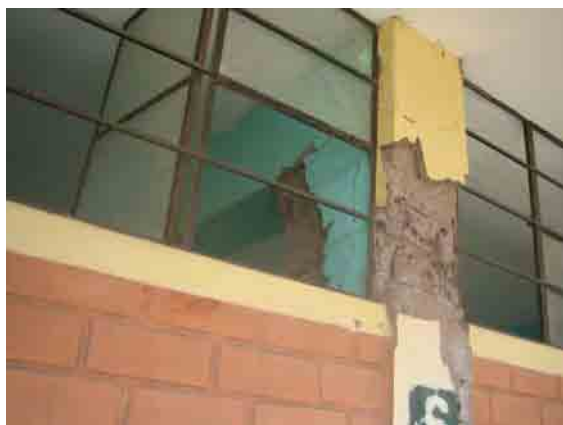
写真一 1 : 柱と梁の切断 (2階柱)
