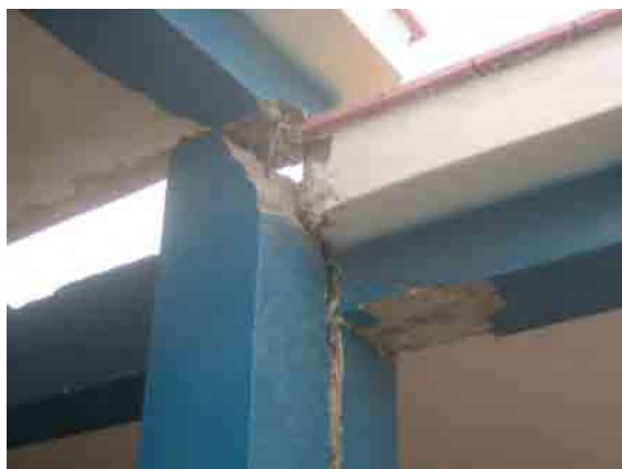
写真一 1 : 柱と梁の切断
