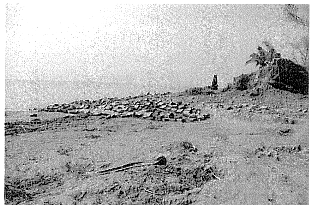
写真-11 調査地点7 破堤地点北側の状況
