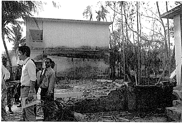
写真-2 高潮により破壊されたハイスクール
