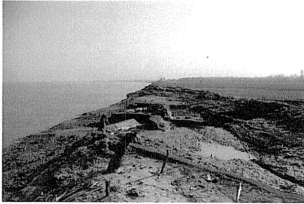
写真-8 調査地点6における河岸の状況（災害時には既に堤防は浸食により失われていた）
