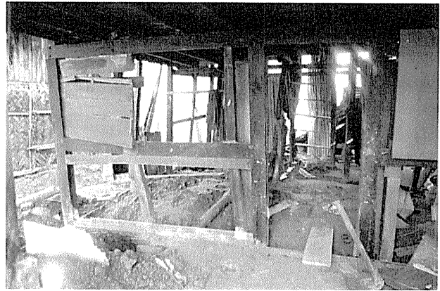
写真-9 調査地点6における家屋被害の状況（1階部分が大きく破壊）
