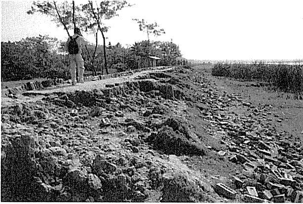
写真－4 地点3の河川沿いのレンガ被覆の Union 連絡道路の被災状況
