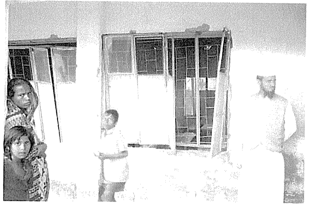
写真-3 高潮により破壊されたハイスクールの窓
