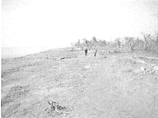
←決壊により防潮堤がなくなった海岸線
