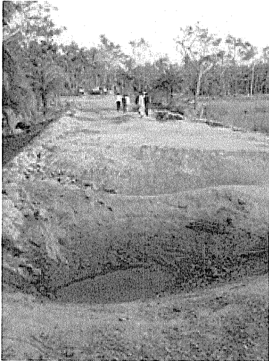
←サイクロン被害で破壊された道路
