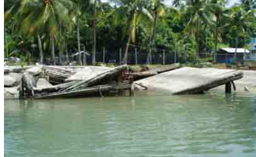
既存ウェワク栈橋 ：施設は築後 47 年。2002 年の地震で半壊し、使用不能となった。栈橋は現地調査後に先方により撤去された。
