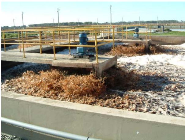
写真 Ensenada 処分場の浸出水処理池
