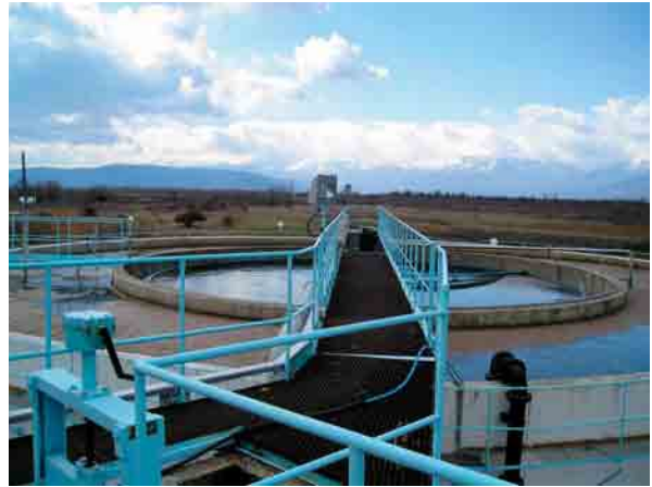
写真10 排出処理施設
