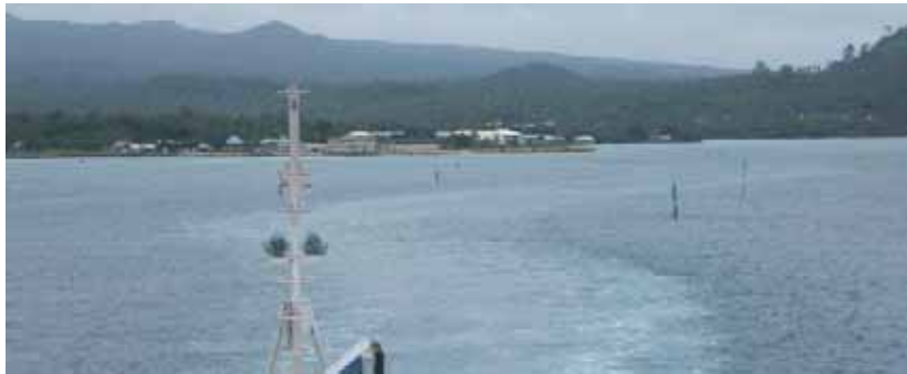
アプローチ（上・中：ムリファヌア港、下：サレロゴガ港） 港への水路は、両港ともに珊瑚礁を開削して設けられたものであり、距離およそ 1.2 km にわたって幅約 50 m～70 m と狭く、最浅部の水深も 3.2 m と浅い。
