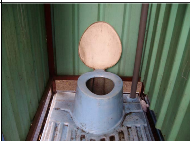
写真 30 : レトリーナ式トイレ。維持管理は良好。 Adilia Irías, Jalapa市, Nueva Segovia県 (N5)
