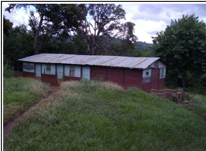
写真7：老朽化したプレハブ教室。1980年代に流行したプレハブ校舎は現在の構造基準を満たさないため解体が必要。Lesbia López, Matagalpa市, Matagalpa県 (Mt6)
