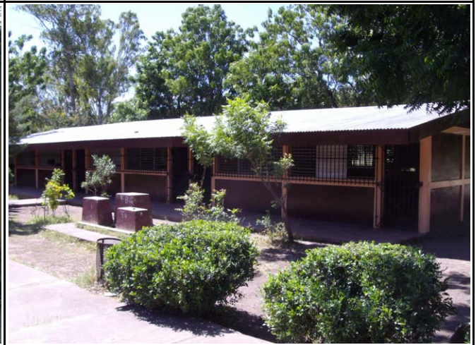
写真 4 : 1981年建設の既存教室。San Isidro, San Isidro市, Matagalpa県 (Mt3)
