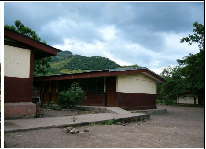
写真 6 : 1970年建設の既存校舎, Quebrada Honda, Matagalpa市, Matagalpa県 (Mt5)
