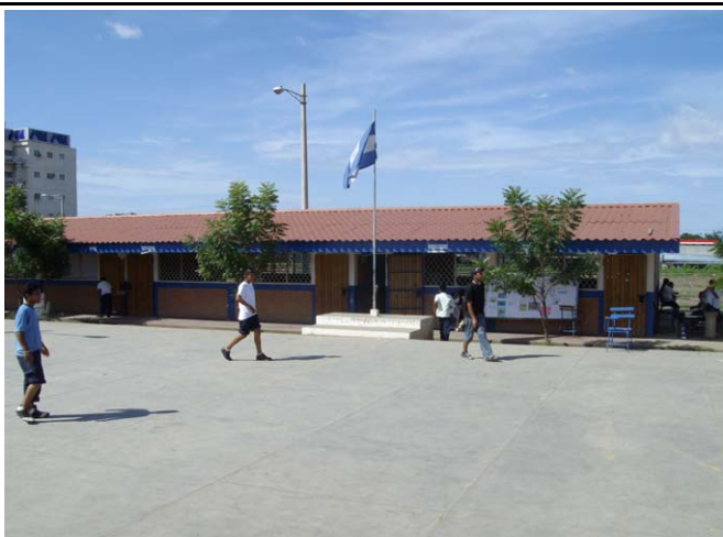
写真21：2005年にドイツKFWの資金で建設されたFISE案件。化粧レンガ積みや、茶色に着色された波形金属屋根の新デザインが特徴。Esculea Primaria Anexo Solidaridad por la Paz
