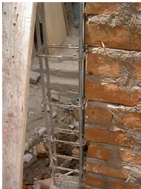
写真 3-11 枠組組積造による住宅建設現場（イカ区）
