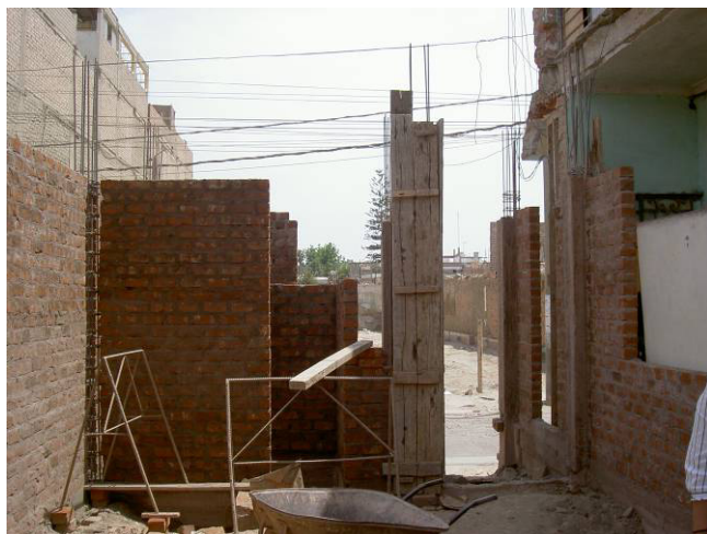
写真 3-11 枠組組積造による住宅建設現場（イカ区）
