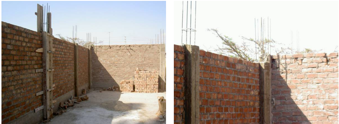
写真 3-12 枠組組積造による住宅建設現場（ピスコ区）
