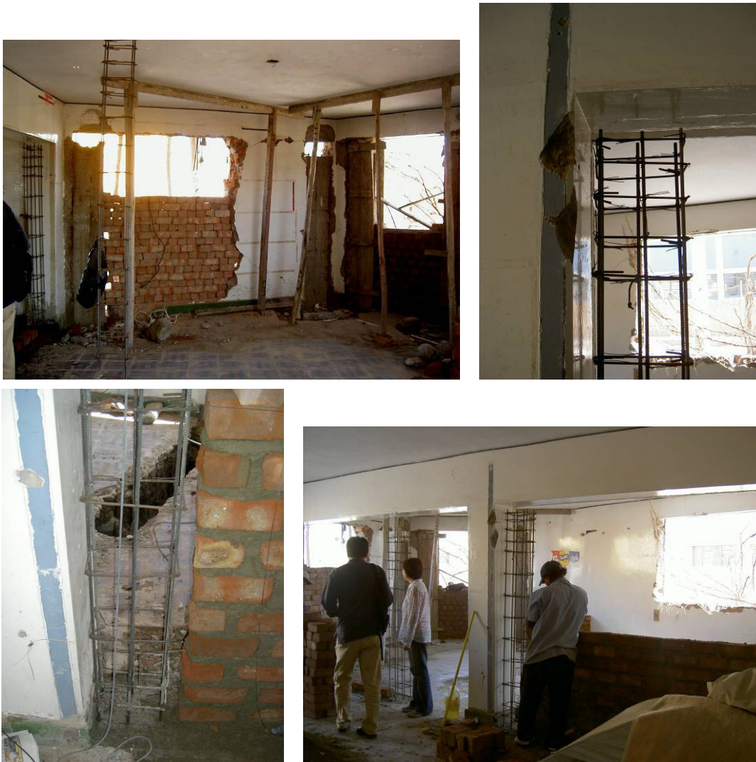
写真 3-13 枠組組積造の補強工事現場 (ピスコ区)
