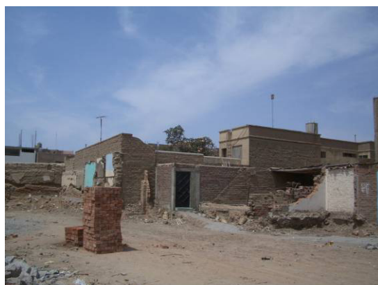
再建用資材が搬入されている敷地。しかし、未だ瓦礫撤去や解体作業が必要な住宅地が数多く存在する。
