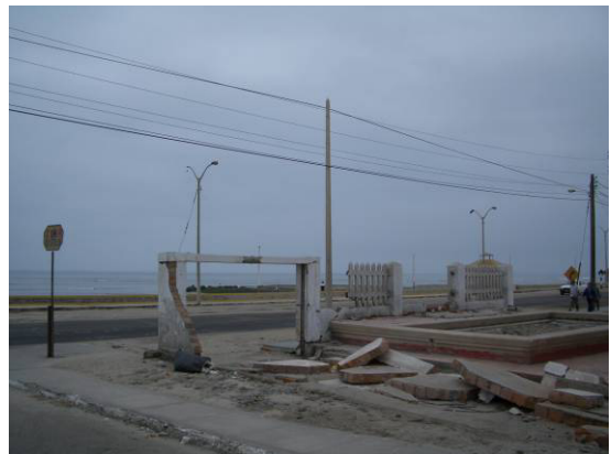
国連事務所前（ピスコ）：未だ再建の兆しはなく、瓦礫撤去作業も終わっていない状態
