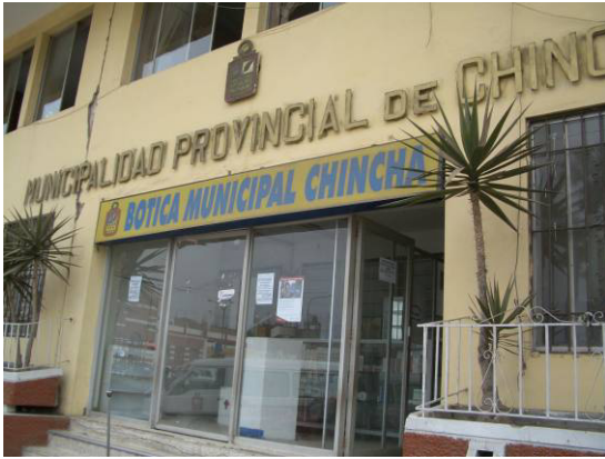
チンチャ郡庁正面：正面玄関左手に大きな亀裂が入っている。
