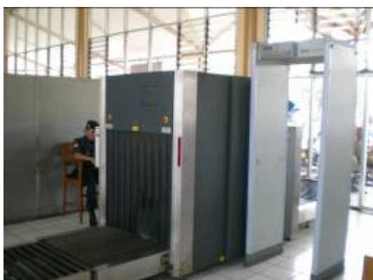
タンジュンペラク港の旅客ターミナルビル内に設置された中型の X 線検査装置及び門型金属探知機
