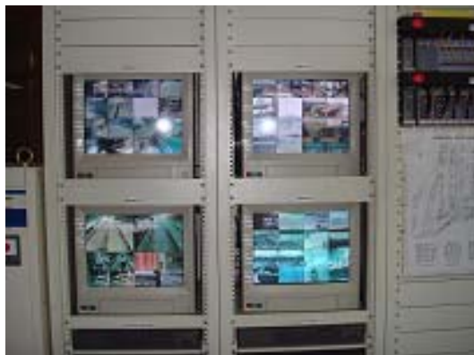
1つのモニタで 16 のカメラを写しており、映像が小さすぎて監視業務の上で問題点を有している
