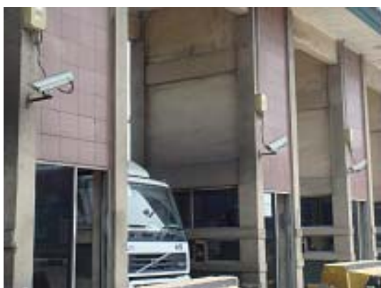
タンジュンプリオク港のゲートに設置された固定カメラ。車輜及び運転手の監視を行なっている。
