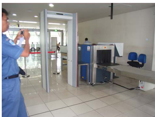
パタム港ノングサプラの国際旅客ターミナルビル内に設置された小型の X 線検査装置及び門型金属探知機。
