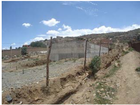
送水ポンプを設置する、シグロヴェインテポンプ場。
