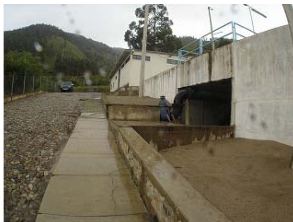
アランフェス浄水場、ろ過池増設予定地。
