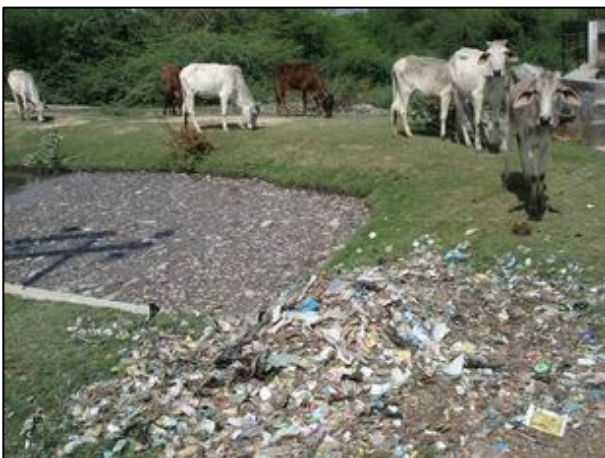
池表層及び場内にゴミが散乱している 安定化池（ブリンダバン市）
