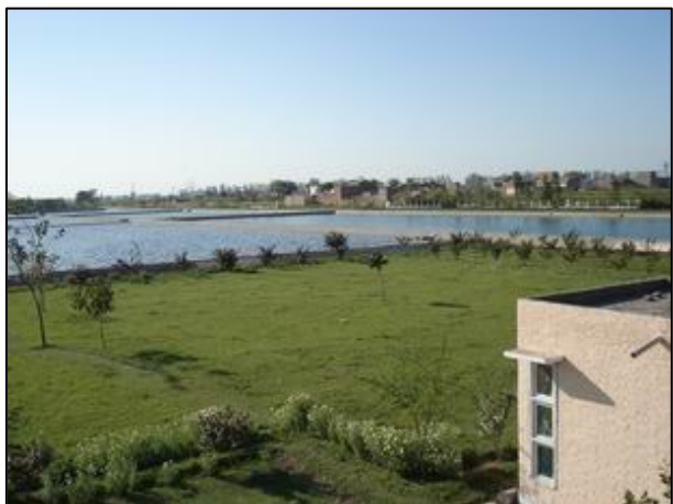
池及び場内が適切に管理されている 安定化池（ガロンダ市）
