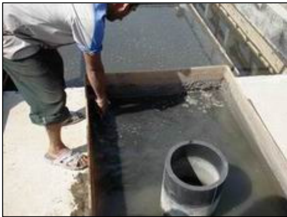
閉塞した分水槽での補修作業 （ガジアバード市）
