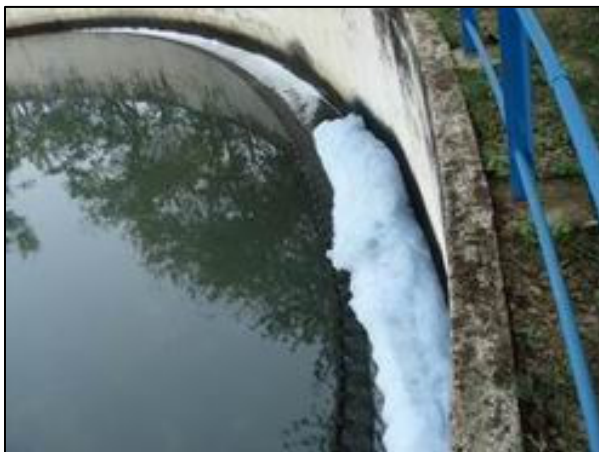
適正に汚泥が引き抜かれている沈殿池 (バラナシ市・最終沈殿池)
