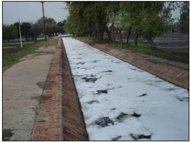
バラナシ市・標準活性汚泥法処理場の放流水（洗剤や染色剤が起因した気泡が目立つ）
