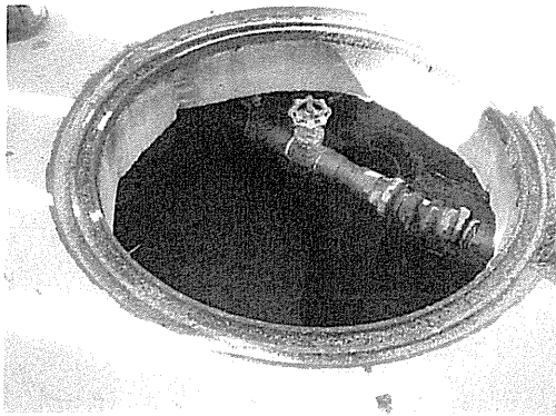
処理施設のマンホール
