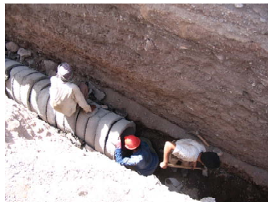
2次製品を用いての横坑の修復
