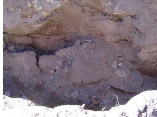
地震で埋没したカナート（横坑）
