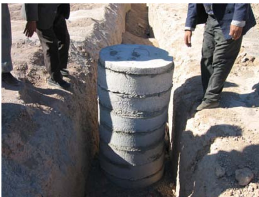
2次製品を用いての竪坑の復旧(2)
