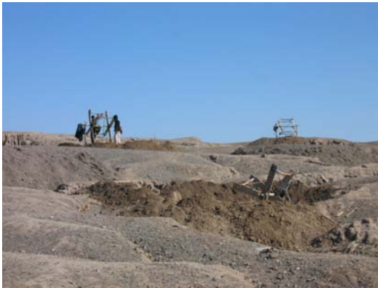
人力による崩壊した横坑の土砂の除去
