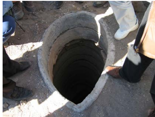
2次製品を用いての竪坑の復旧(1)
