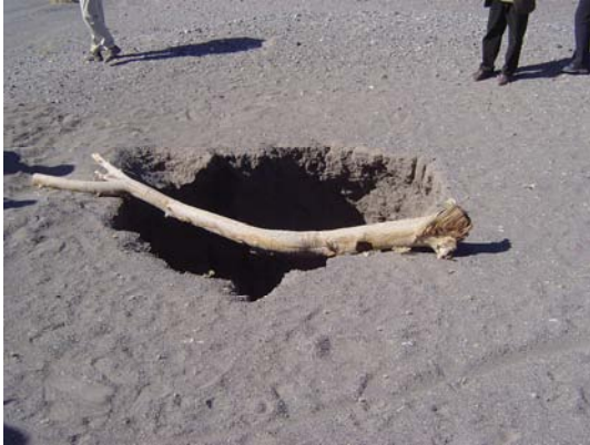
地震によって崩壊したカナート（竪坑）
