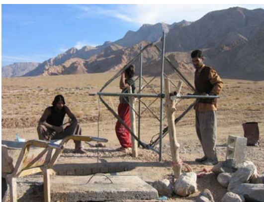
伝統的なカナート掘削のための機具
