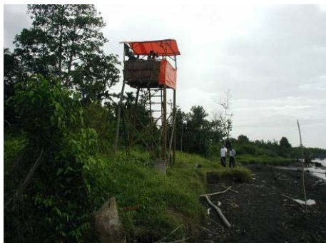
写真5-1：観測棟の設置状況
