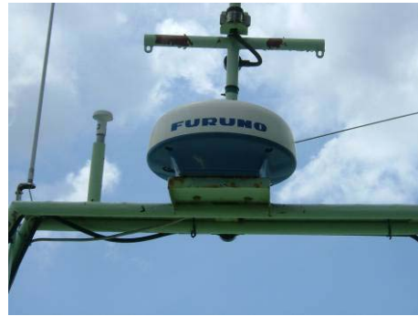
写真 5-8 : レーダースキャナー設置状況
