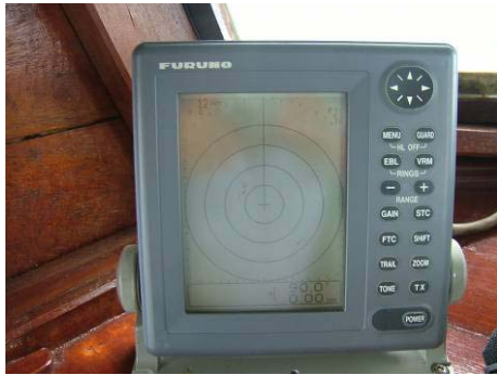
写真 5-7 : 船用レーダーの設置状況
