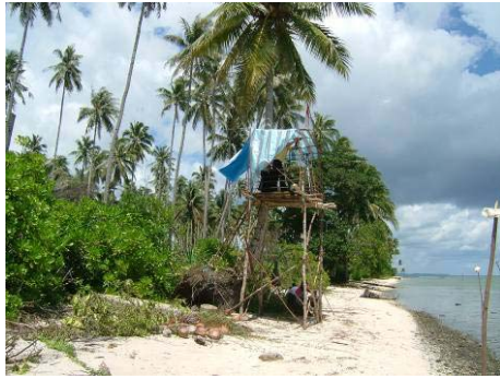
写真 5-5 : 観測棟設置状況
