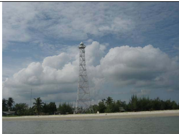
写真 5-1： サイト遠景（ルパット島北端、海岸線に位置する。航行援助局が管理・運営する灯台が設置されている。日本財団の援助により財団法人マラッカ海峡協議会が寄贈・設置した。）
