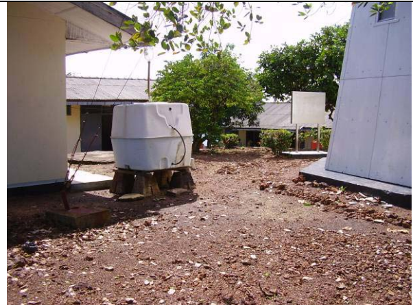
写真 2-4: 雨水集水タンク (雨水を集水し、生活用水に当てている。電力は自家発電機による。)
