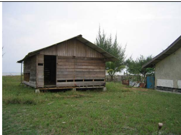
写真 5-3： 既設倉庫（発電機棟及び燃料タンク建設予定地にあるため、先方政府負担により撤去する。）
