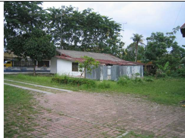
写真 8-3： 沿岸無線局員用宿舎（沿岸無線局敷地内に設置されている。）
