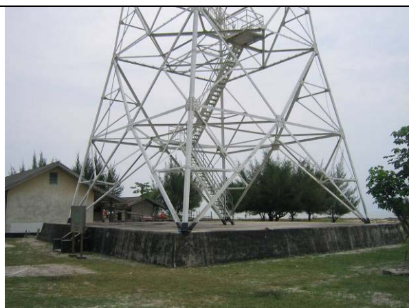
写真 5-5： 既存灯台の鉄塔基礎の状況
