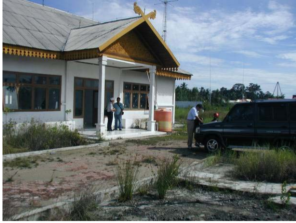
写真 7-1： 沿岸無線局舎（航行援助局が管理運営する沿岸無線局が置かれている。）
