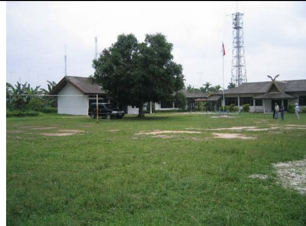
写真 8-1： ドマイ沿岸無線局の状況（1）（市街地外れに立地しており、電力などの基本インフラは整備されているが、電力事情は良くない。）
