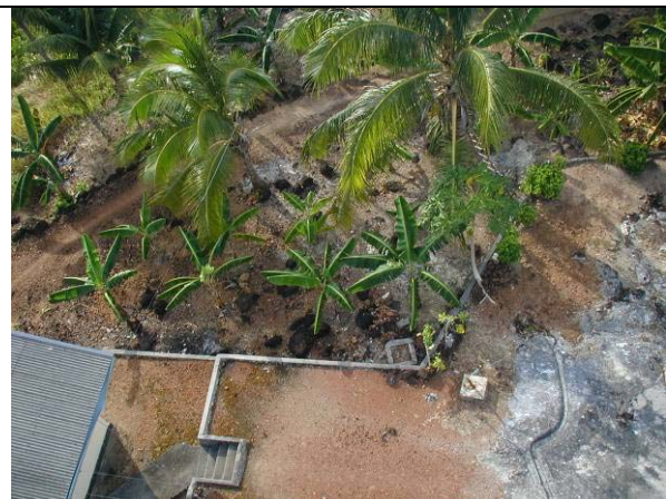
写真 4-3: レーダー／通信用鉄塔建設予定地（既存の道路（未舗装）は先方政府負担により移設。）
