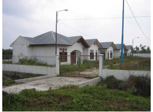
写真 7-2： 沿岸無線局職員宿舎（沿岸無線局敷地内に職員用の宿舎が設けられている。）
