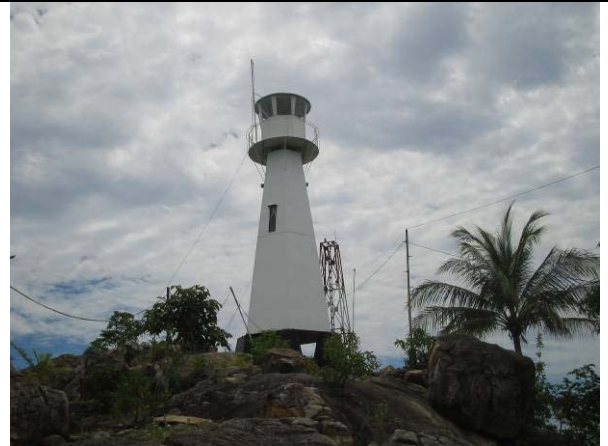
写真 1-2: ヒュー・クチール既設灯台（オランダ統治時代からの灯台で、建造は 1888 年とある。）
