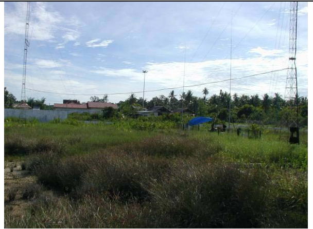
写真 7-4： 施設建設予定地の状況（写真中央がレーダー/通信用鉄塔の建設計画地点。地盤は軟弱な粘性土層である。）
