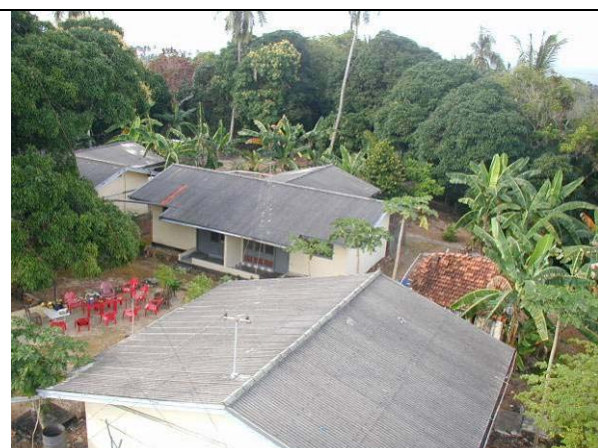
写真 4-5: 灯台職員宿舎（航行援助局が管理する灯台の維持管理運営を担当する職員のための宿舎）
