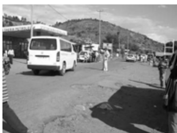
Bas côté détérioré au No.15+40
