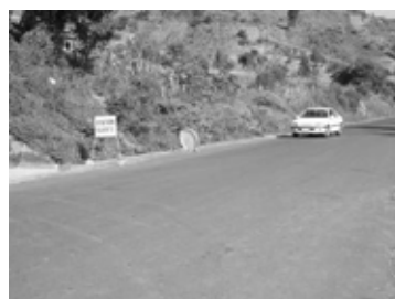
Limite de la section concernée par le projet (Point de contrôle de Police)
