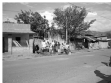
Robinet d'eau commun pour le secteur
