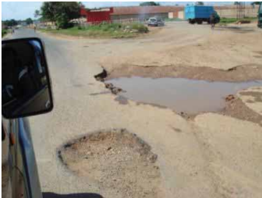
Revêtement routier détérioré
