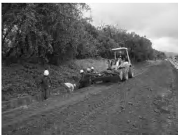
Date : 14/11/2007 ~ 30/11/2007 Activity : RN7 Sub-base Scarification Clearing the Big Size Stones Sta. -0+025 ~ 0+240 Left Side Sta. 0+280 ~ 1+500 Left Side
