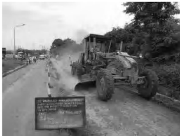
Date : 14/11/2007 ~ 30/11/2007 Activity : RN7 Sub-base Leveling and finishing Sta. -0+025 ~ 0+240 Left Side Sta. 0+280 ~ 1+500 Left Side
