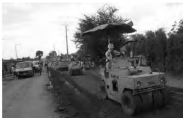
Date : 14/11/2007 ~ 30/11/2007 Activity : RN7 Sub-base Soil Spreading Sta. -0+025 ~ 0+240 Left Side Sta. 0+280 ~ 1+500 Left Side
