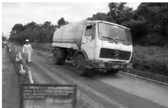
Date : 14/11/2007 ~ 30/11/2007 Activity : RN7 Sub-base Moisturizing Sta. -0+025 ~ 0+240 Left Side Sta. 0+280 ~ 1+500 Left Side
