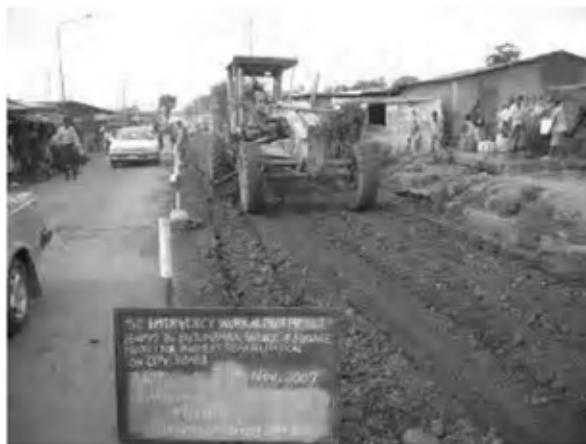
Date : 14/11/2007 ~ 30/11/2007 Activity : RN7 Sub-base Soil Mixing Sta. -0+025 ~ 0+240 Left Side Sta. 0+280 ~ 1+500 Left Side
