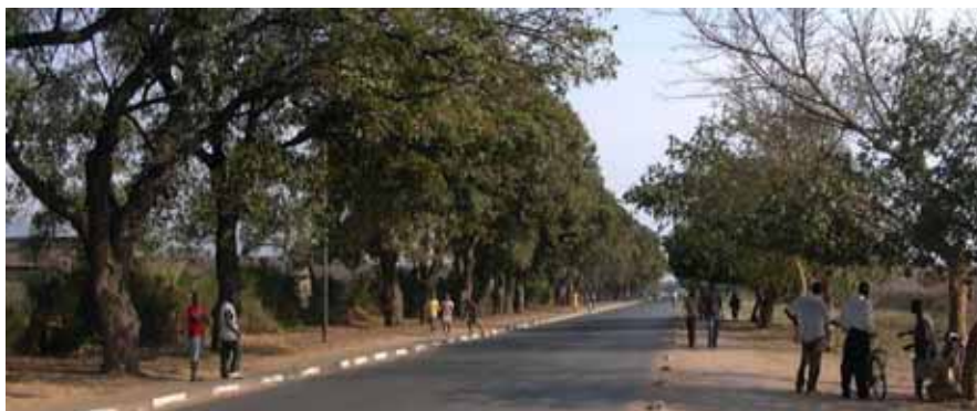
ンガガラ地区における南北軸沿いの沿道植栽
