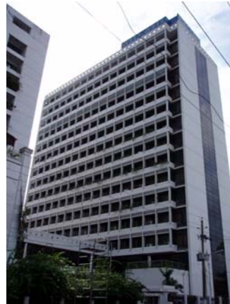
RDEC ビル全景
