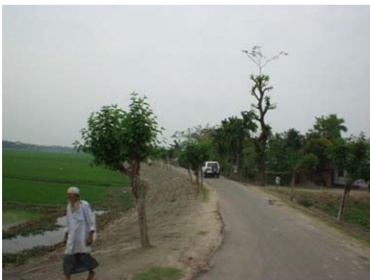
コンクリートによる法面保護
