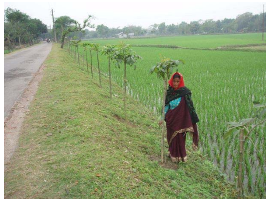
植生による道路法面保護
