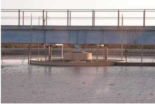
写真 3-5 アドラ処理場の最初沈殿池
