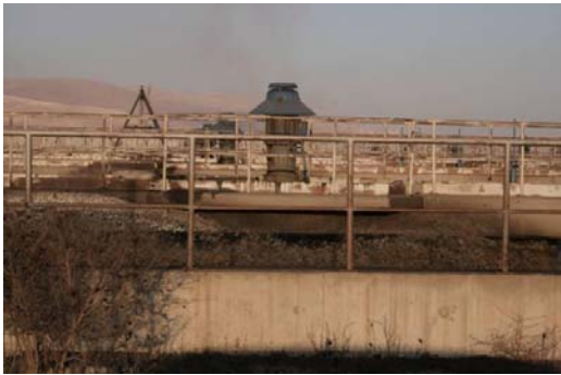
写真 3-6 アドラ処理場の反応タンク（写真左）と最終沈殿池（写真右）
