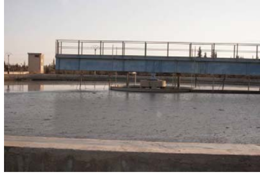
写真 3-5 アドラ処理場の最初沈殿池
