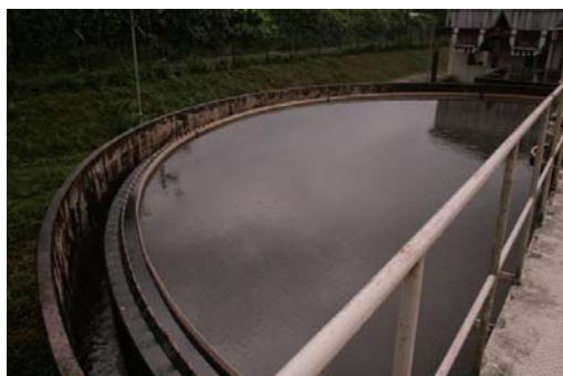
写真 2-14 最終沈殿池
