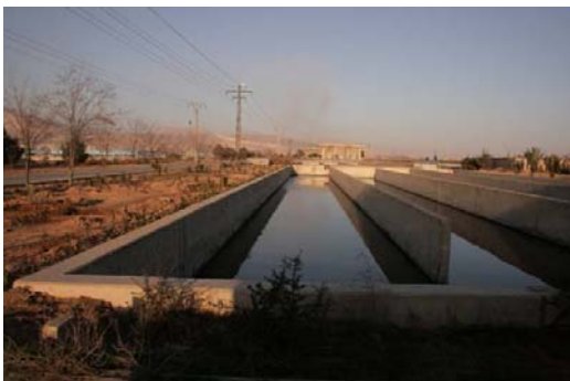
写真 3-7 アドラ処理場の消毒タンク（左）と放流口（右）
