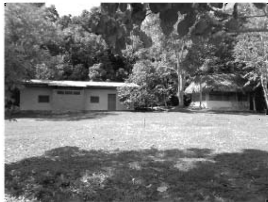
敷地内の既存家屋（コンクリートブロック組積造）
