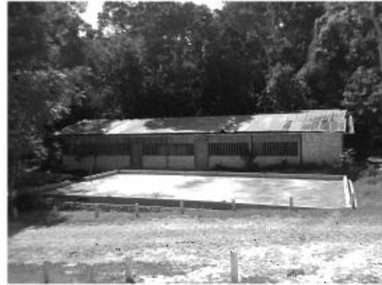
手前：新設収蔵庫（現在床工事で中断）、 奥：既存収蔵庫 1
