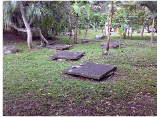
容量が不足する度に新たに掘られてきた浸透枡
