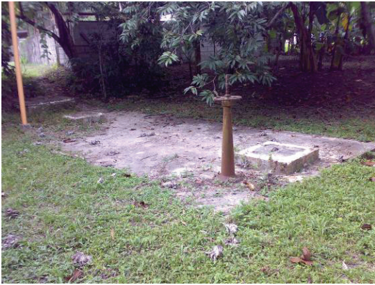
汚泥の引抜が行われておらず既に機能不良の浄化槽
