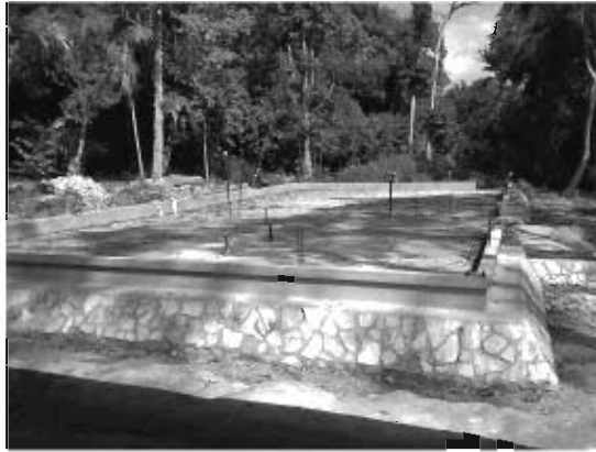
建設中の資料センター（現在床工事で中断）
