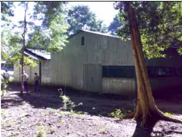
写真 15: 収蔵庫2。収蔵庫1に隣接して単管パイプの骨組とトタン板で組まれた仮設倉庫。
