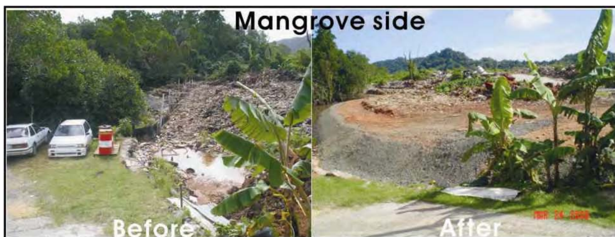
■Mドック埋立処分場内周辺の改善前と後（マングローブ側）
