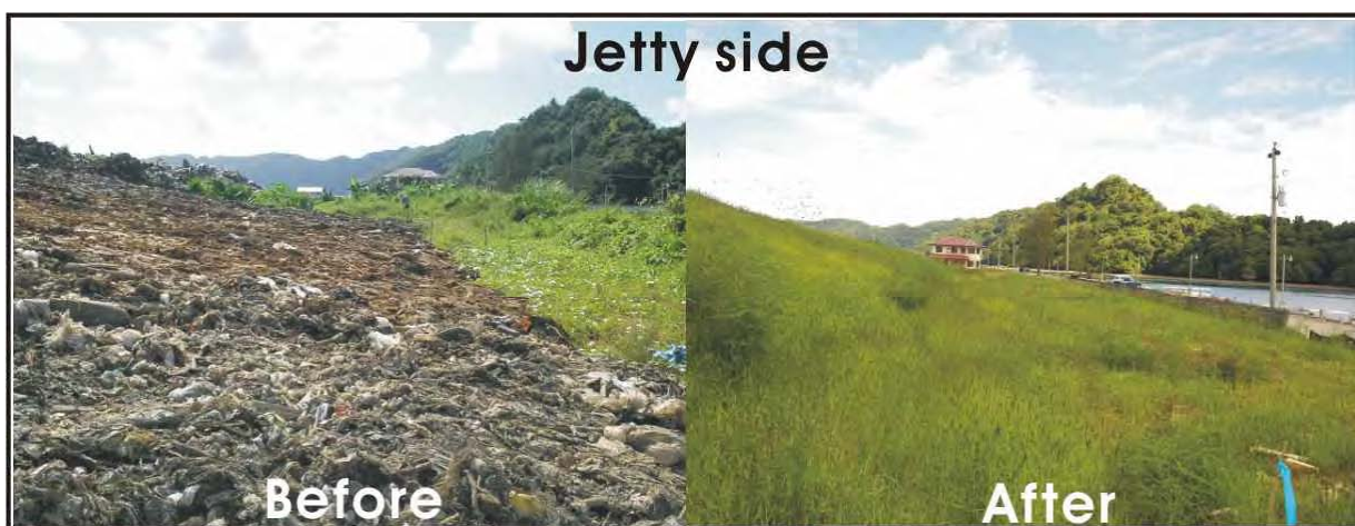
■Mドック埋立処分場内周辺の改善前と後（桟橋側）
