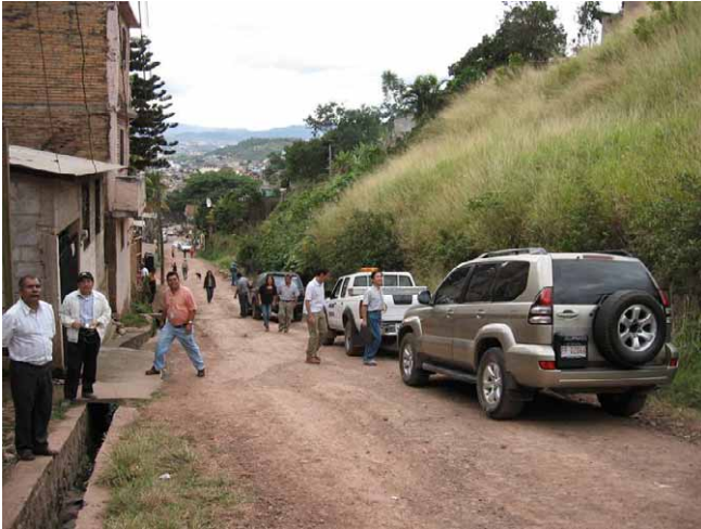
地滑り末端側部（下段ブロック） ハリケーン・ミッチで地滑りが発生した時に 右上方斜面が崩壊し、家屋の1階部分が土砂 で埋まった。
