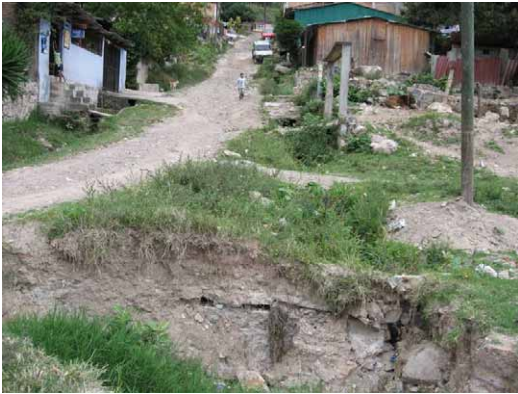
エル・レパルト地区の上部ブロック。 雨水排水の洗掘により削り取られている箇所 が見られる。
