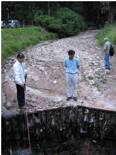
溪流下流部のスリットダム（堆積厚約 1.2m）。土砂は毎年撤去している。
