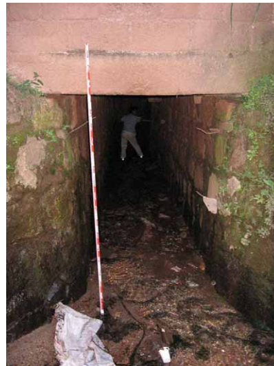
映画館や下流の市街地を横断する石張り暗渠（縦 1.7m×幅 1.3m）。
