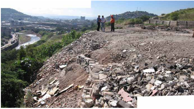
瓦礫など建設廃材による造成地。 (延長約 70m、幅 20～30m、高さ最大約 10m)
