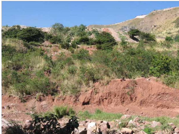
エル・ベリンチェ地区末端部 上部に建設廃材の盛土が見られる。 中部～下部は崩壊地である。赤色土砂は泥質のチキート層起源。
