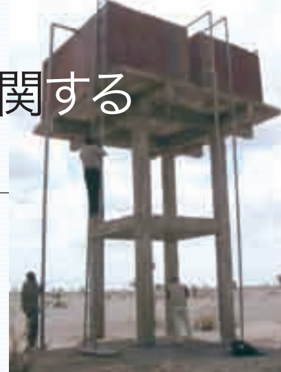
エチオピア：鋼製タンク式高架水槽
