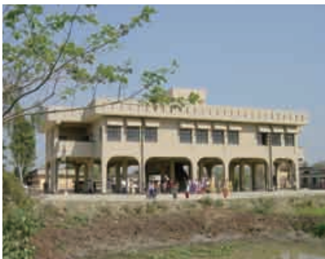
2001年2月に完成した日本の無償資金協力により建設されたシェルター兼初等学校の例
