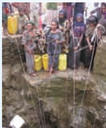
深さ15メートル程度の手彫り井戸から水をくみ出す
