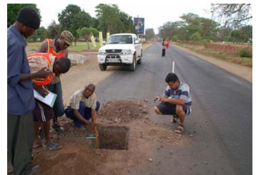
テストピット調査による試料採取状況
