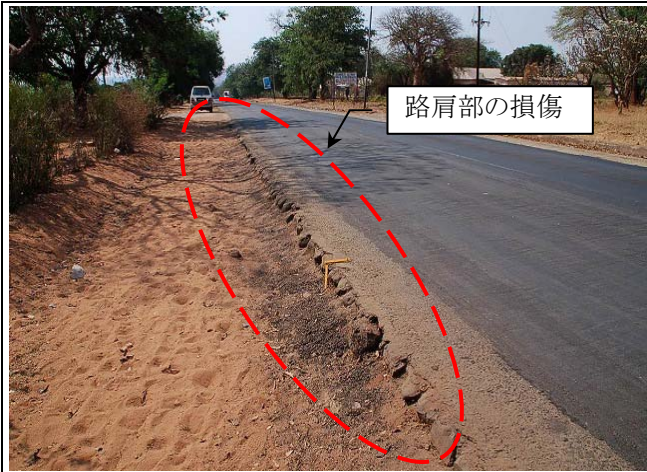
写真-1: 起点部付近のホールディングメンテナンス前の状況。路肩部が損傷して、車道部に影響が出始めている。
