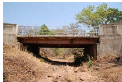
カビラ橋の現況
