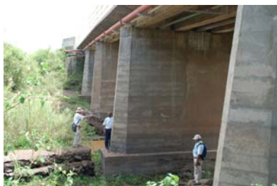
マランバ橋の現況
