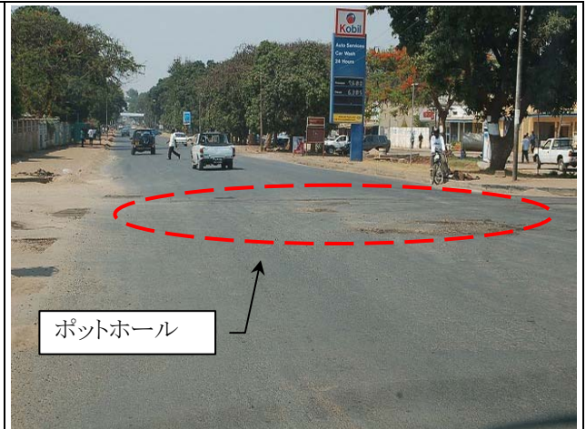
写真-2: 市街地の M10 道路交差点部付近 大型車輛の切り返しにより、ポットホールが多く見られ、損傷している舗装表面。
