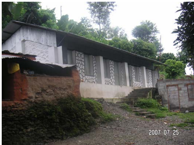
ダディン郡 Nava Durga Primary School 外観（日本の無償資金協力による校舎）
