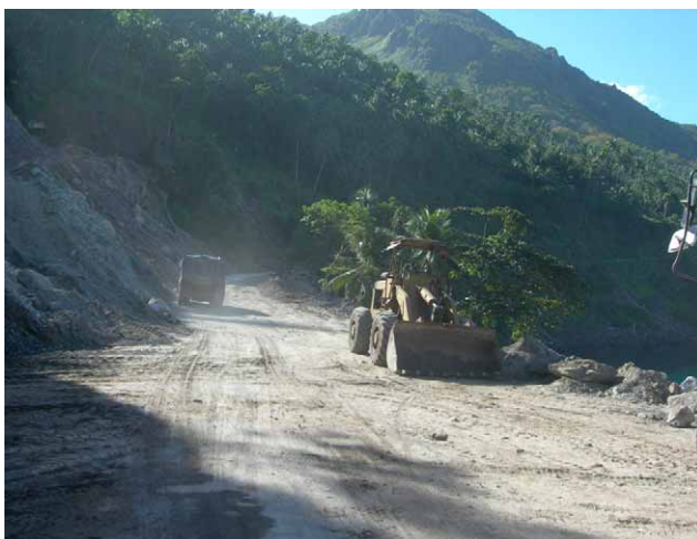
法面安定保護工の施工現場。高さ約 90m、延長約 400mの土工事で着工後すでに 5 ヶ年を経過し今年完成の予定。
