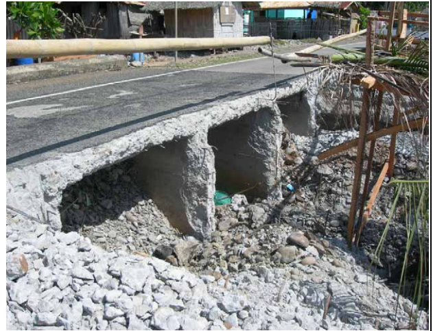
老朽化したボックスカルバートの改修現場。
