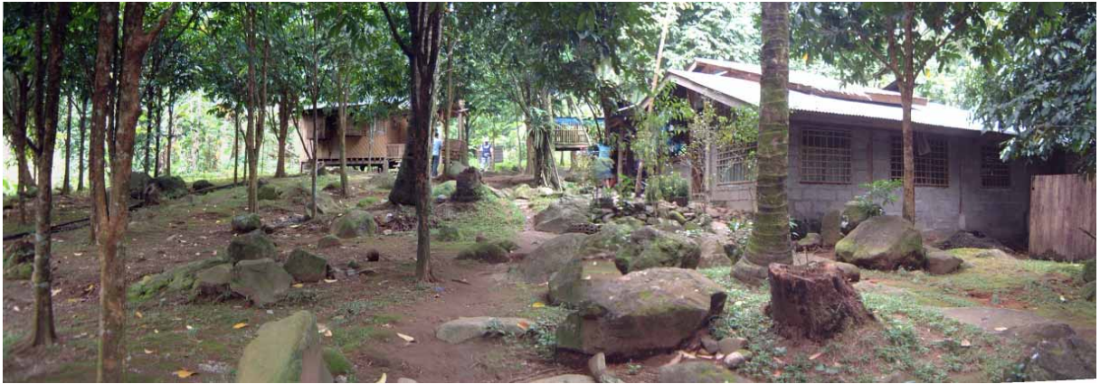
図-2.4.8 コモン砂防ダムへのアクセス道路の状況
