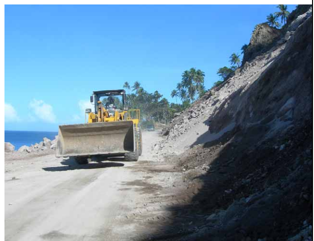
同左。 大型工事のため車両交通規制が実施されている。
