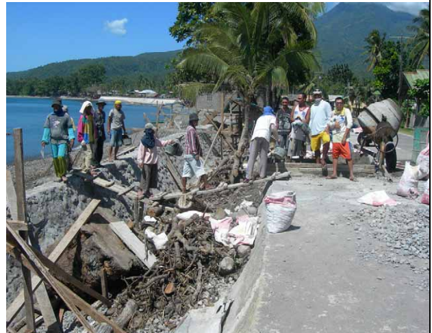
同じく昨年末の台風による海岸護岸の改修現場。
