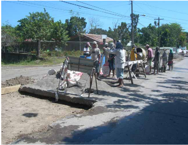
亀裂の入ったコンクリート舗装の打ち替え現場。
