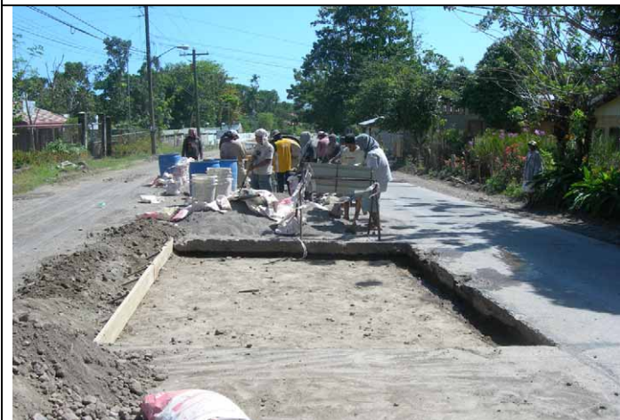
老朽化したコンクリート舗装を打ち替えている現場。 DPWH カミギン技術事務所、維持管理部の発注による。
