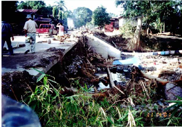
写真④ ポントドカルバート: 国道越水による下流側盛土の洗掘 【上: 被災直後(Nov.14,2001)、下: 現在(Feb.01,2008)】
