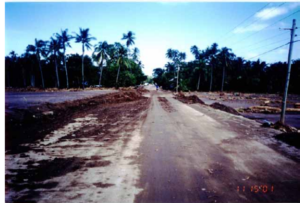
写真⑦ 泥流(左から右へ)が越水した国道の状況 【上: 被災直後(Nov.15,2001)、下: 現在(Feb.01,2008)】
