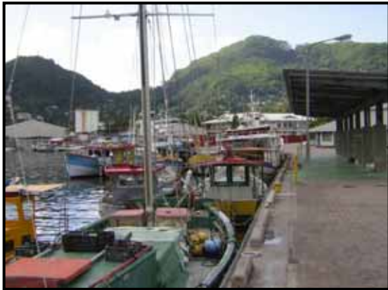
写真-1 ビクトリア漁港 陸揚げ岸壁に漁船が多重係留されている。
