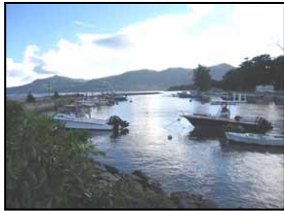
写真-14 ベル・オンブレ漁港 休憩岸壁及び泊地
