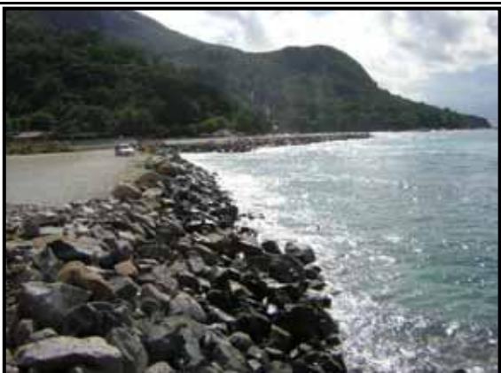
写真-17 ベル・オンブレ漁港 埋立地及び護岸 (「セ」国政府により整備中である)
