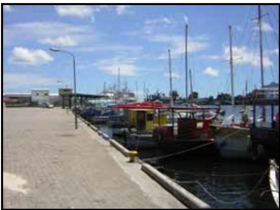
写真-3 ビクトリア漁港 休憩岸壁には零細漁船が満杯状態で縦係留されている。（津波災害によって被災した岸壁背後のエプロン舗装は2006年にJICAフォローアップ援助により復旧された）
