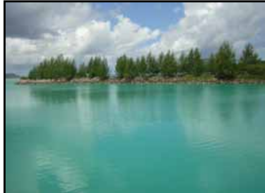
写真-12 プロビデンス地区 計画サイト 既存防波堤及び泊地 (「セ」国政府により整備された)
