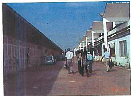
写真-6 KNUST 実験棟施設
