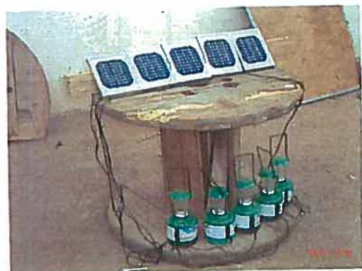
写真-22 同充電中のソーラーランタン
