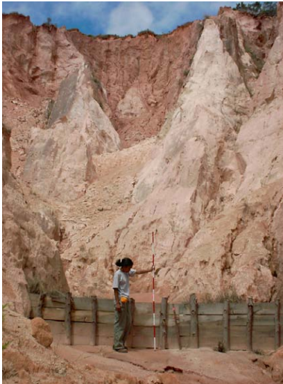
No.21 Restauration de la végétation dans le cadre du projet pilot de lavaka Travaux de rétention de la terre à l'aide de sacs de sable à lavaka
