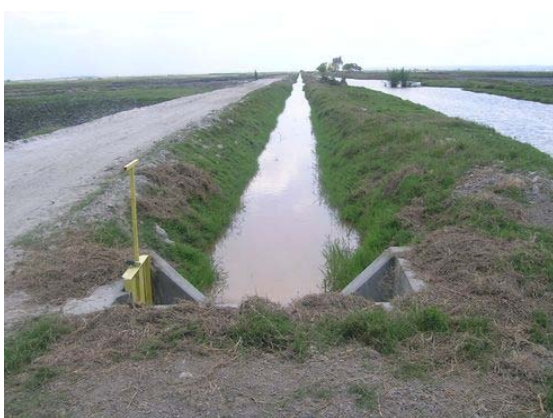
No.9 Système du canal principal du P5 de la zone d'irrigation du PC23 À gauche se trouvent le canal tertiaire de drainage et la piste d'exploitation
