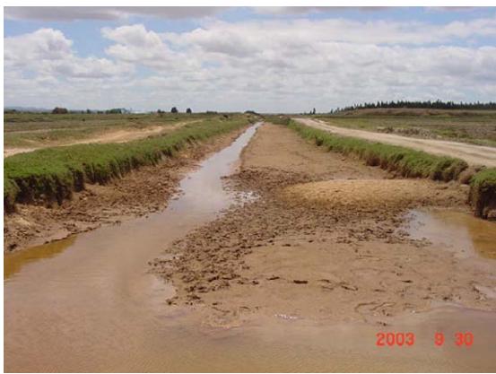
No.7 Zone d'irrigation du PC23 du système du fleuve Sahamilahy Accumulation de sable dans le canal principal du P1
