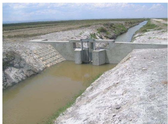
No.10 PC23 灌漑地区 P5 幹線用水路系統 三次排水路流水再利用水位堰上げ施設
