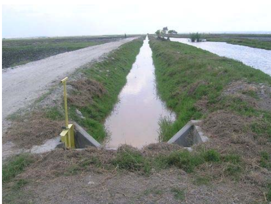
No.9 PC23 灌漑地区 P5 幹線用水路系統 右上手より三次排水路・用水路・農道
