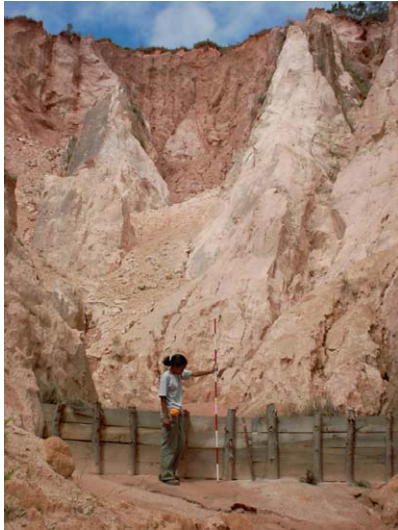
No.21 ラバカ内植生回復パイロット事業 活動型ラバカ土囊積み土留め工
