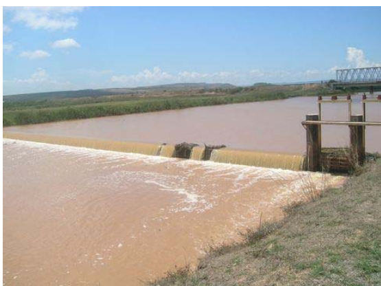
No.5 Sahabe 川雨期増水時の流況 PC23 灌漑地区 P1 幹線用水路仮頭首工 左岸下流側
