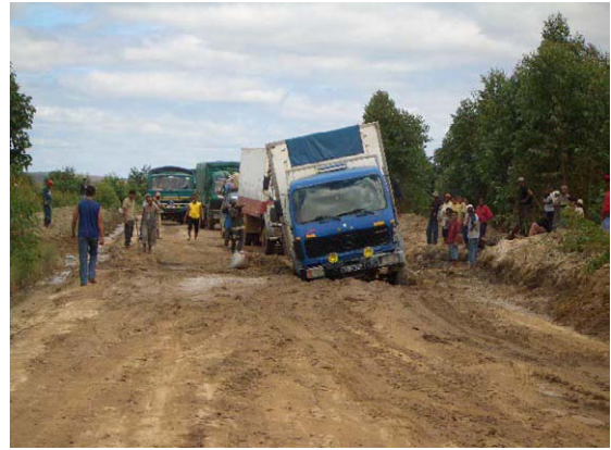
No.4 アロチャ湖周辺地域へのアクセス道路 国道 44 号線未舗装区間の雨期の状態
