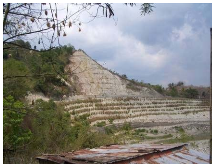
長大切り土のり面 A09 Viqueque
