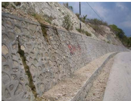
石積み擁壁 A09 Viqueque
