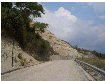
長大切り土のり面 A09 Viqueque
