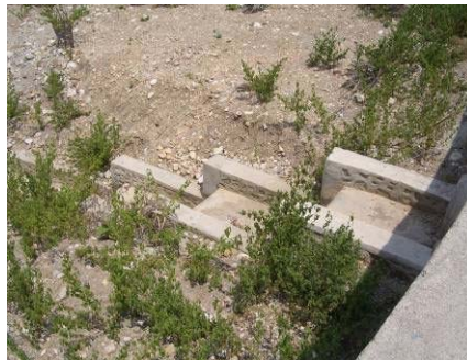
階段式縦排水工 A01
