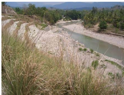
ふとん籠による護岸工 A09 Viqueque
