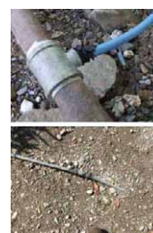
T 字管にビニールホース で分水、接続部はゴム
