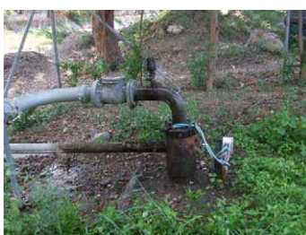
2001 年 JICA により掘削
