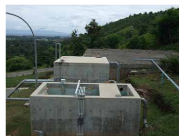
着水井と洗浄タンク
