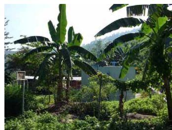
浄水場下には配水池
