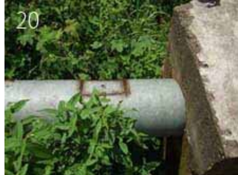
排砂のために管を切断
