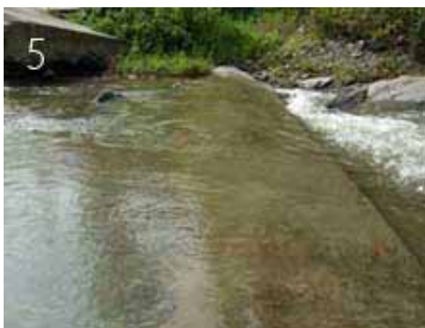
補修後の導水管は 10cm 厚のコン クリートで保護
