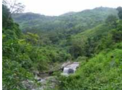
ベモス取水口付近状況
