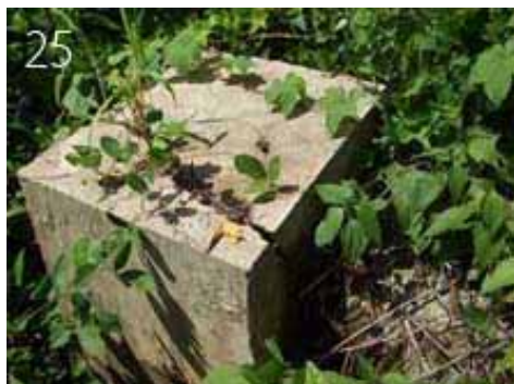
落石のため架台にひび割れ
