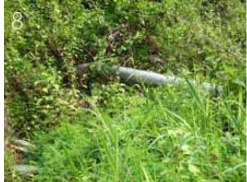
右岸部の配管露出部
