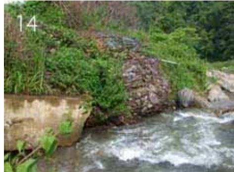
14 左岸部の蛇籠による法面保護
