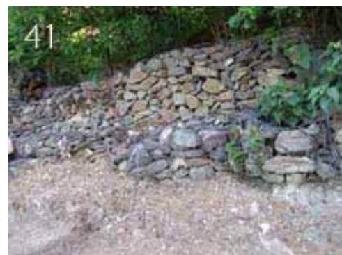
浄水場入り口横の法面保護工
