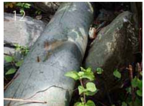
落石による大きな凹み
