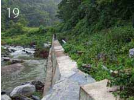
BPT より 100m 下流側にある補修された区間
