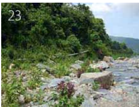
洪水で 100m に亘って配管が宙に浮き、折損、DNSAS が補修
