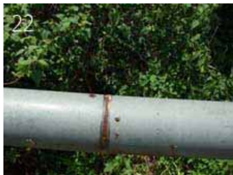
排砂のためにここも切断 (中央部)
