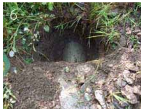
左岸部の導水管は 30cm の土被り
