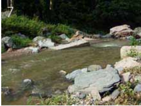
直下に流された保護コンクリート
