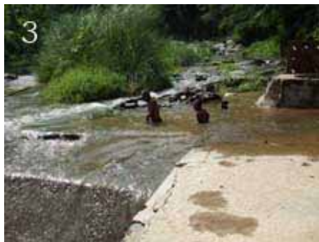
雨期は毎日流入土砂を手作業で排砂
