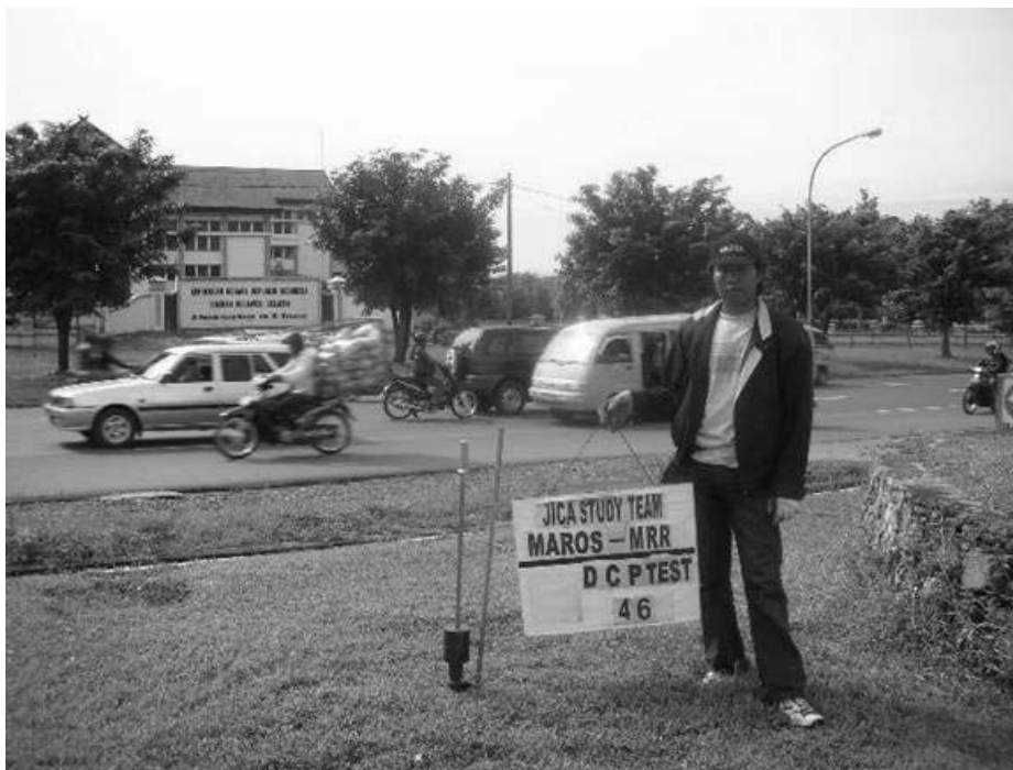
Gambar E-2.3 Uji DCP untuk Pelebaran Jalan
