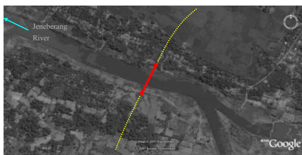
図 7.19 マミナサバイパスのジェネベラン No.1 橋
