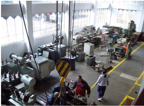
Begana 訓練センター内（変圧器の修繕）
