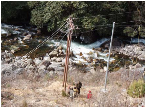
RE4 の建設現場 (33kV)
