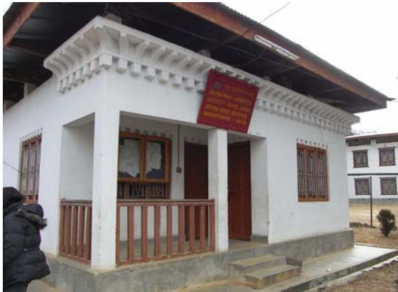
Wangdi Phodrang ESD 事務所
