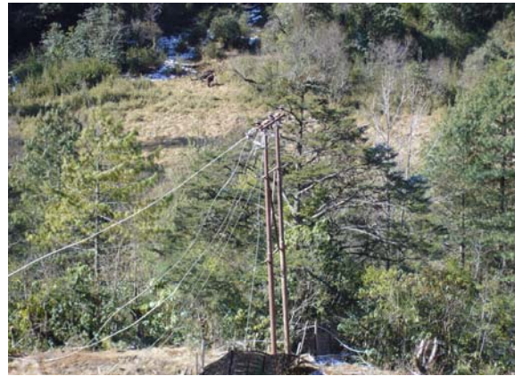
RE4 の建設現場 (33kV)
