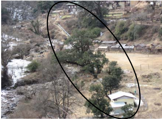
Chendebji マイクロ水力発電所 (e7 Project)
