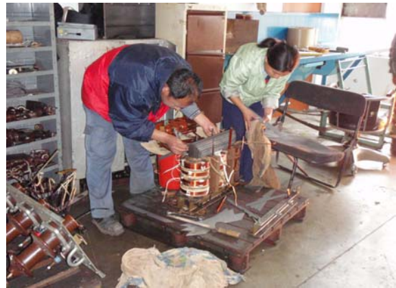
配電柱上変圧器の巻き線修繕
