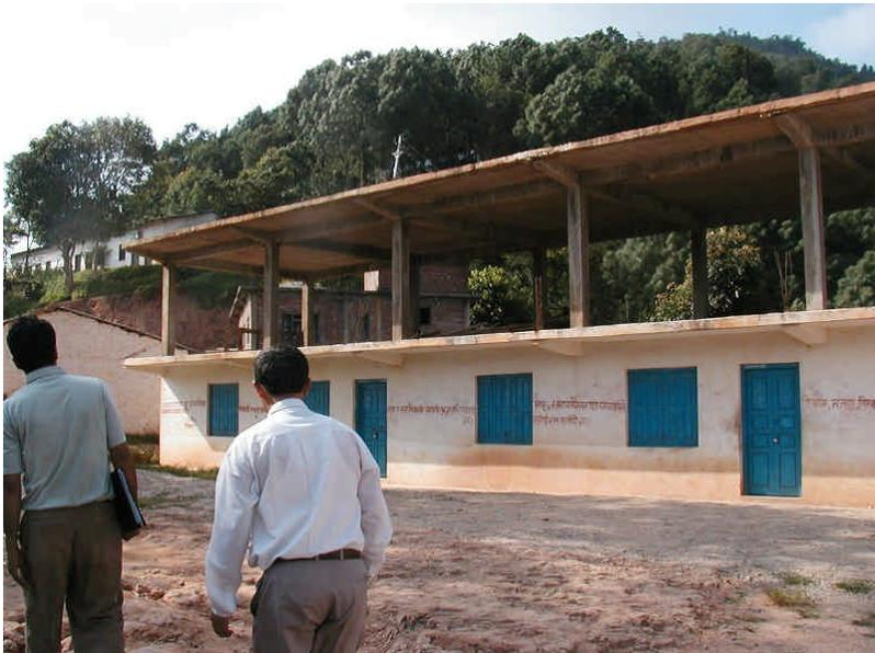
鉄筋コンクリートラーメン構造の校舎
