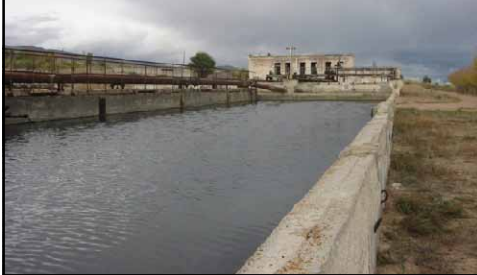
曝気槽：曝気装置が機能していないため生物処理が行えず、単に下水が通過している。
