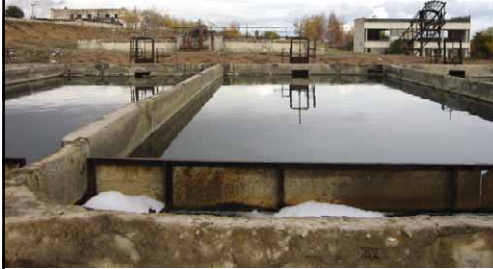
塩素接触タンク
