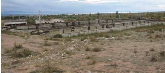
曝気槽：曝気装置が機能していないため生物処理が行えず、単に下水が通過している。
