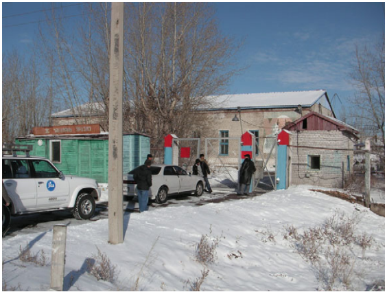
第2ステーション（送水ポンプ室全景）
