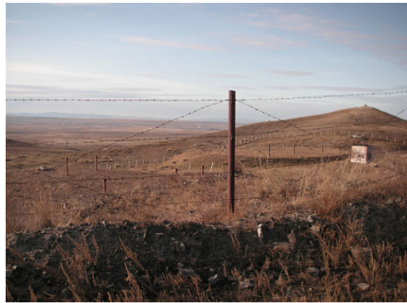
配水池（覆土されている）
