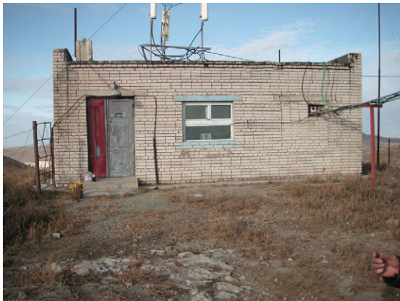
配水池（監視小屋）
