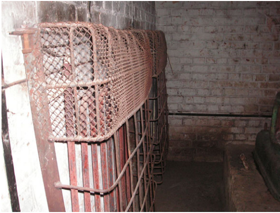
第1ステーション（稼動中の井戸ポンプ室、電力消費の一因となっているヒーター）
