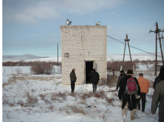
第1ステーション(稼動していない井戸ポンプ室)
