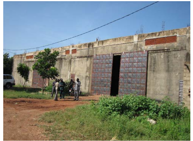
写真10 農業省の借り上げ倉庫：2KRで調達した肥料は農民に引き渡されるまでこの倉庫で保管されている。民間会社より月75万FCFA（約15万円）で借りている。2,000～3,000tほど収容可能。
